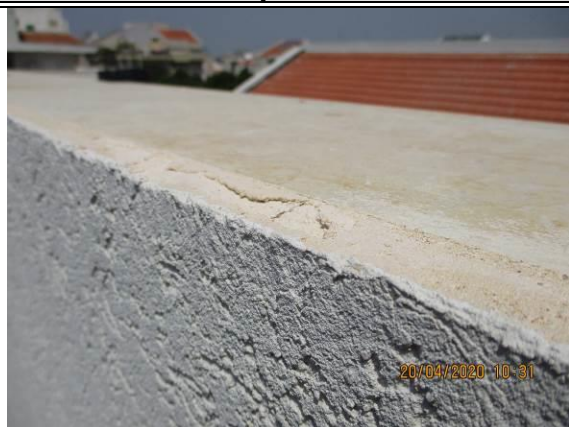
6. השלמת טיח לא תקינה ולא באה בחשבון לפי המצב יש לצפות להתפרקות טיח בשל המים שיחדרו דרך הסדק
