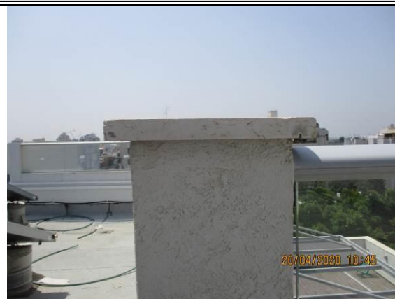
5. קופינג אופקי + אף מים בצד הלא נכון + חסר כל תועלת בשל הצמדתו לקיר
