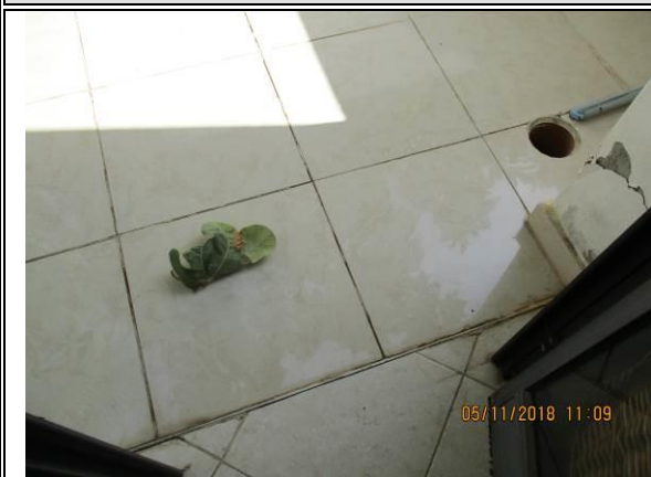
6. ריצוף לא בטיחותי + שיפועי ריצוף לא תקינים + ריצוף פנים פולש לתחום המרפסת+ קולטי מי גשם לא תקינים
