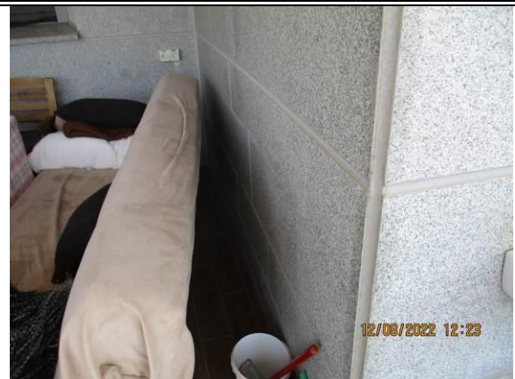
5. ריצוף בסמוך לקיר זה <<<
